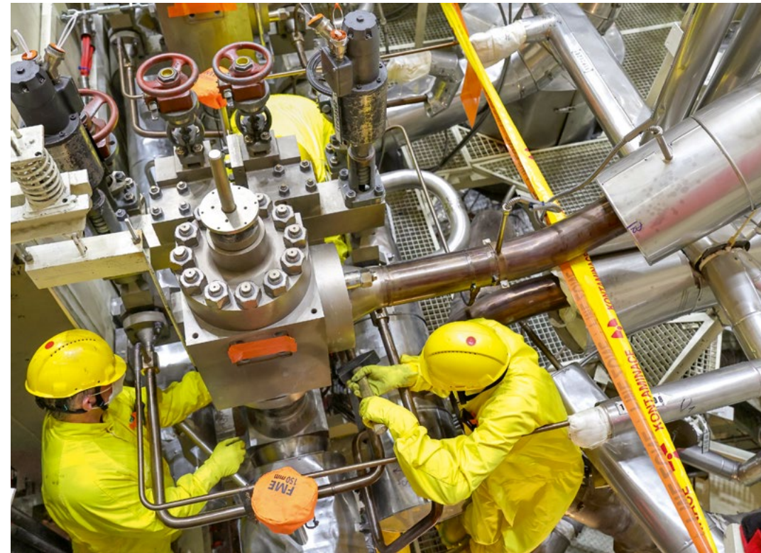
← Obr. 16: Pravidelná údržba sestavy uzlu pojistných ventilů kompenzátoru objemu podle plánu údržby (JE Temelín, 2025)
