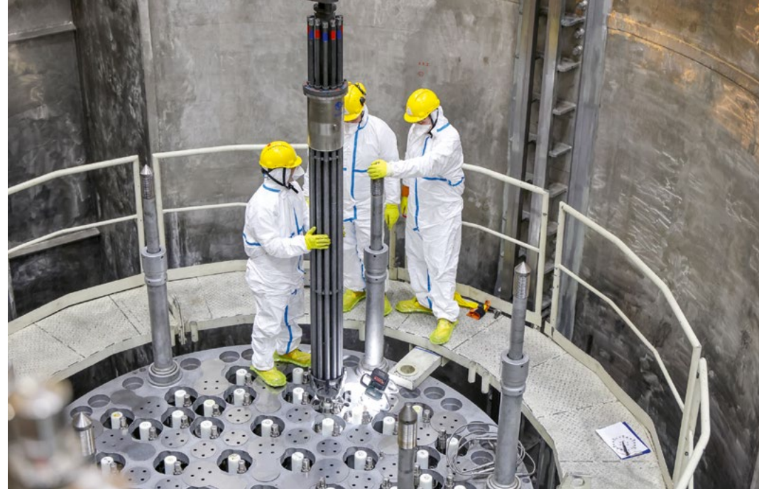
Obr. 17: Povolování přírub nátrubků vnitroreaktorového měření teploty a neutronového toku na horním bloku reaktoru (JE Temelín, 2025)
