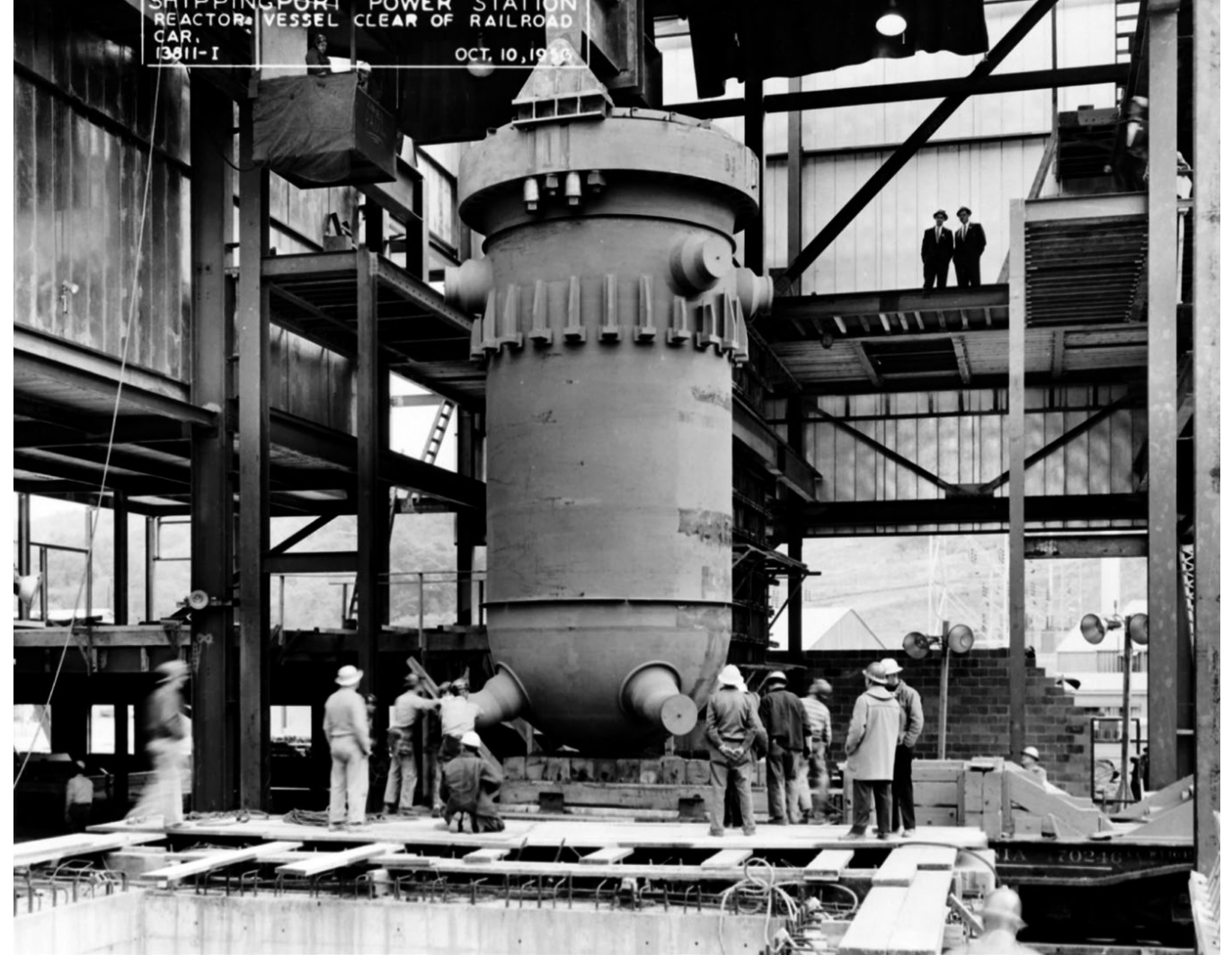
↑ Obr. 6: Instalace reaktorové nádoby v jaderné elektrárně Shippingport dne 10. října 1956 (zdroj: http://hdl.loc.gov/loc.pnp/hhh.pa1658/photos.135430p , United States Department of Energy, Naval Reactors Program)
