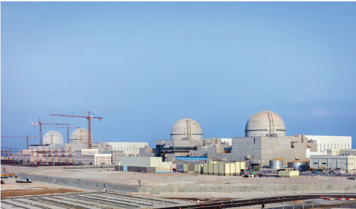
↑ Obr. 9: V současné době probíhá přechod k reaktorům III. generace. Těmi jsou korejské APR-1400, jejichž menší varianta bude i v Dukovanech. Na snímku jaderná elektrárna Barakah se čtyřmi reaktory APR-1400 (zdroj Emirates Nuclear Energy Company)
