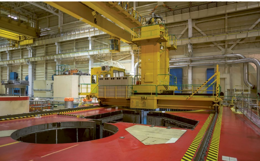
→ ↑ ↓ ← ↶ ↷ ↸ Obr. 7: Postament reaktora – výmena paliva na 4. bloku (zdroj Slovenské elektrárne, a.s.)
