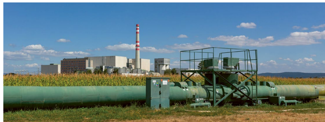
→ Obr. 9: Tepelný napájač EBO do okolitých miest (zdroj Slovenské elektrárne, a.s.)
