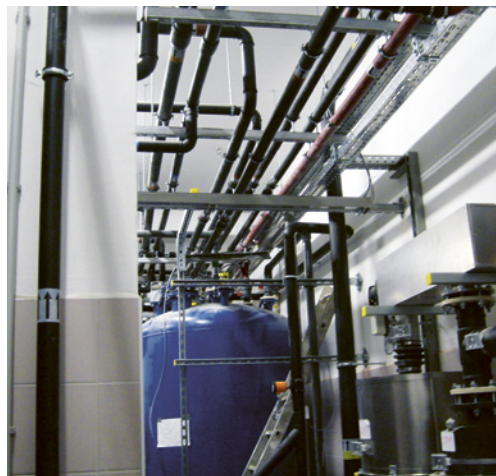
Obr. 4 Systém dočasného uskladnenia tekutého rádioaktívneho odpadu – ten sa tu uskladňuje vo veľkých nádržiach do doby, kedy jeho rádioaktivita poklesne na úroveň, umožňujúcu vypustenie odpadu do verejnej kanalizácie
