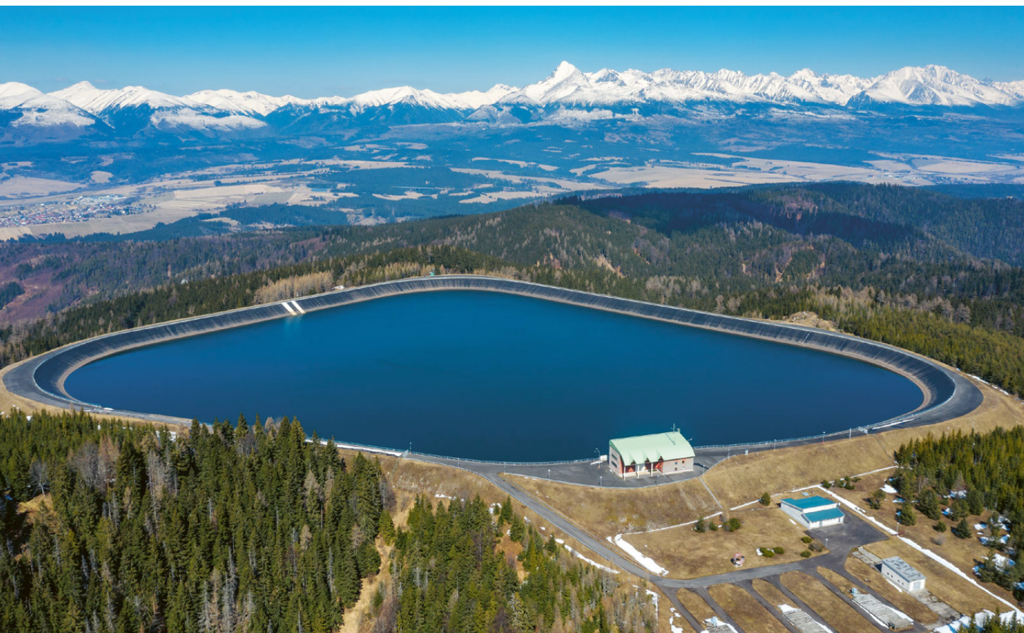
↑ Obr. 4 Prečerpávacía vodná elektrárň Čierny Váh (zdroj Slovenské elektrárne, a.s.)
