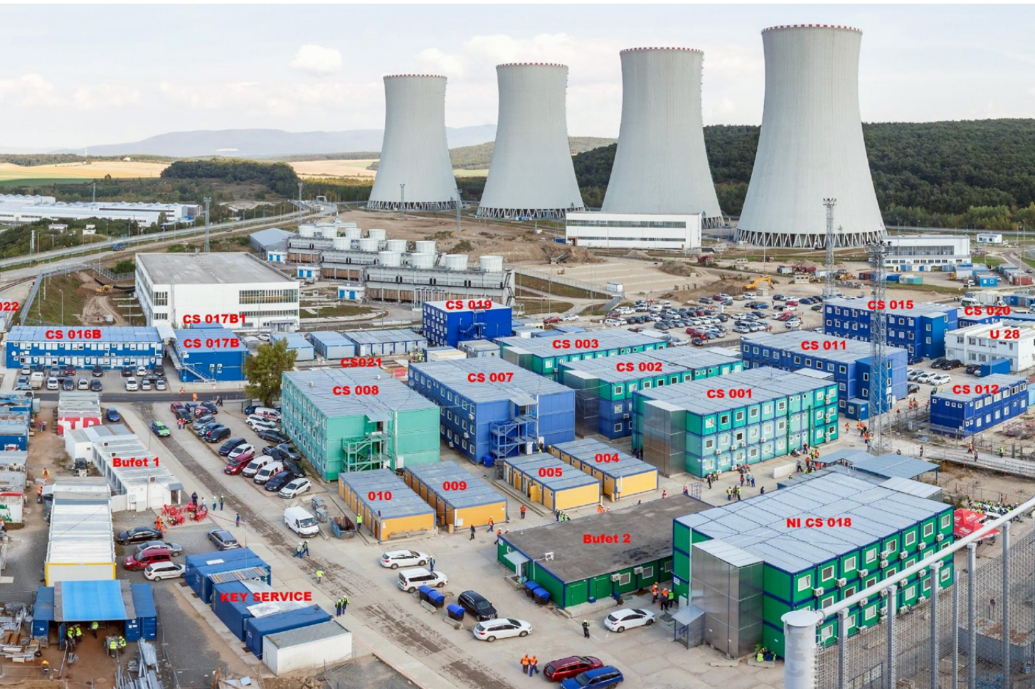
↑ Obr. 2 Staveniště při výstavbě 3. a 4. bloku Jaderné elektrárny Mochovce
