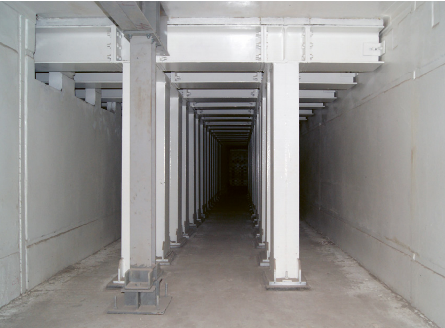
↑ Obr. 3 Realizované ocelové konstrukce
