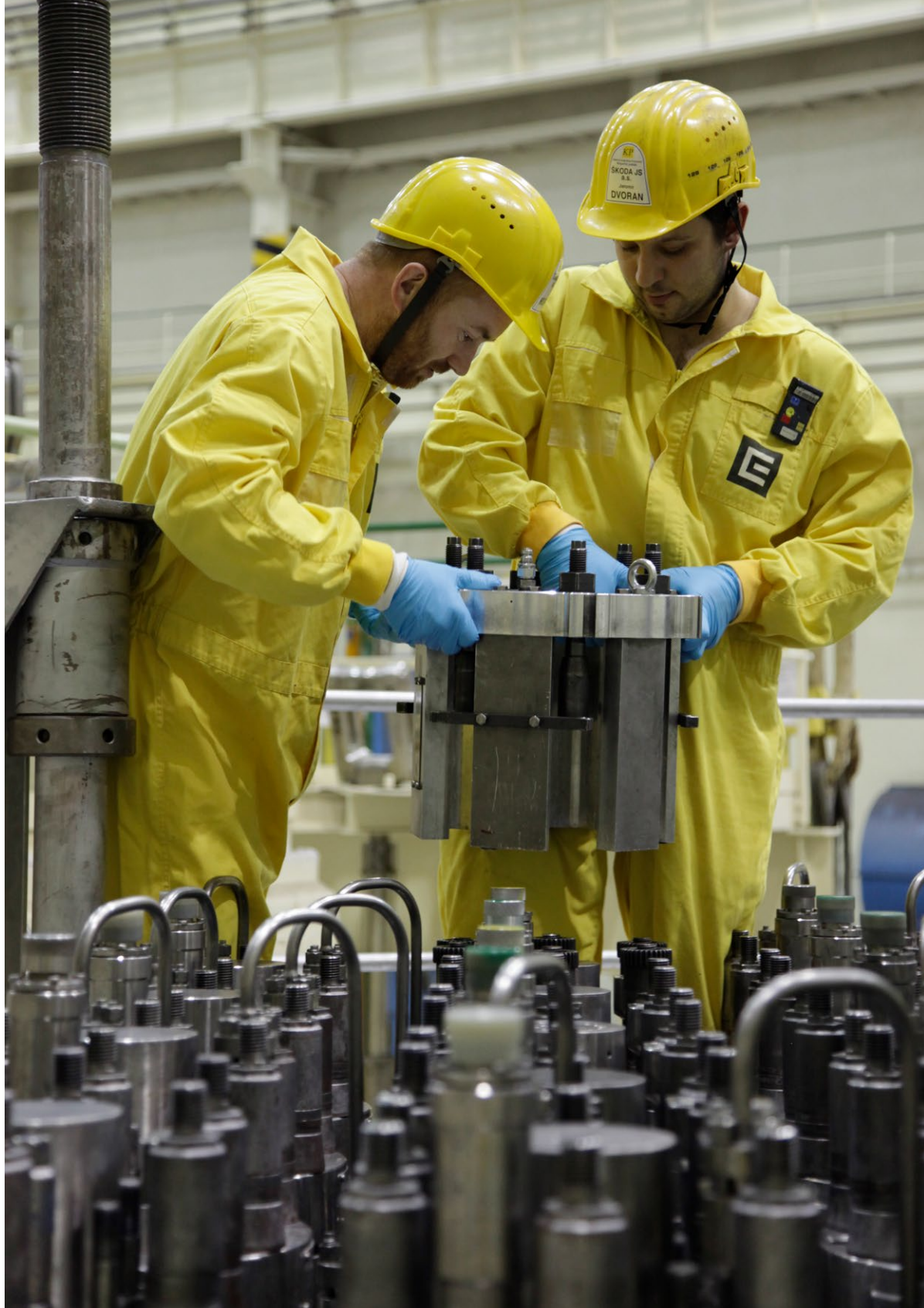
| Servisní práce při odstávce na JE Dukovany |
