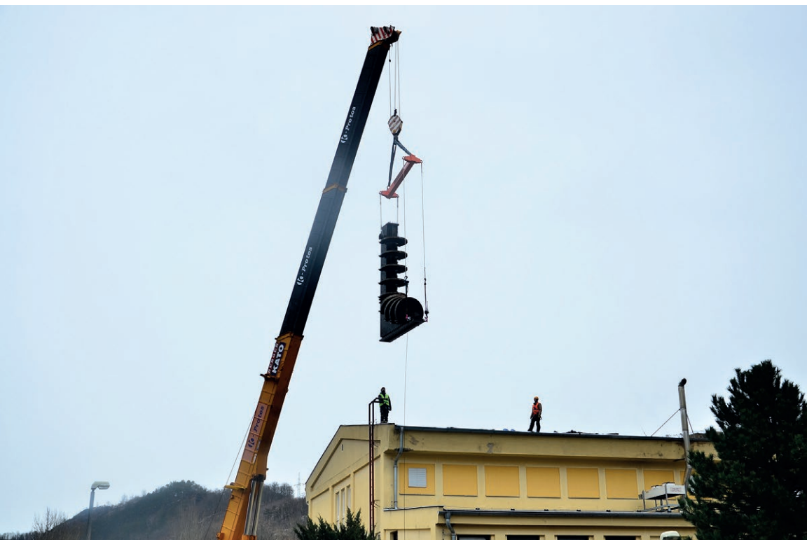
Obr. 8: Usazení chladicího kanálu
