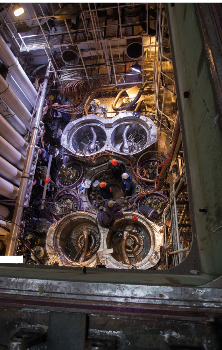
Kompletace reaktoru v reaktorové části plavidla
