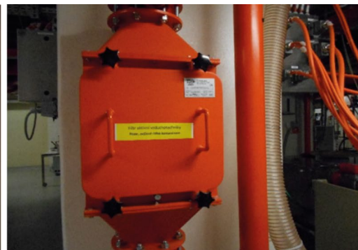
▲ | Obr. 9: Výměna HEPA filtrů aktivní vzduchotechniky |
