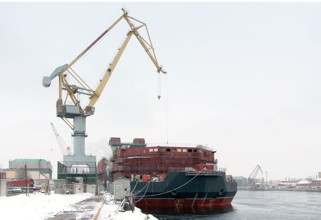
Výstavba plovoucí JE v Baltických loděnicích v Petrohradě
